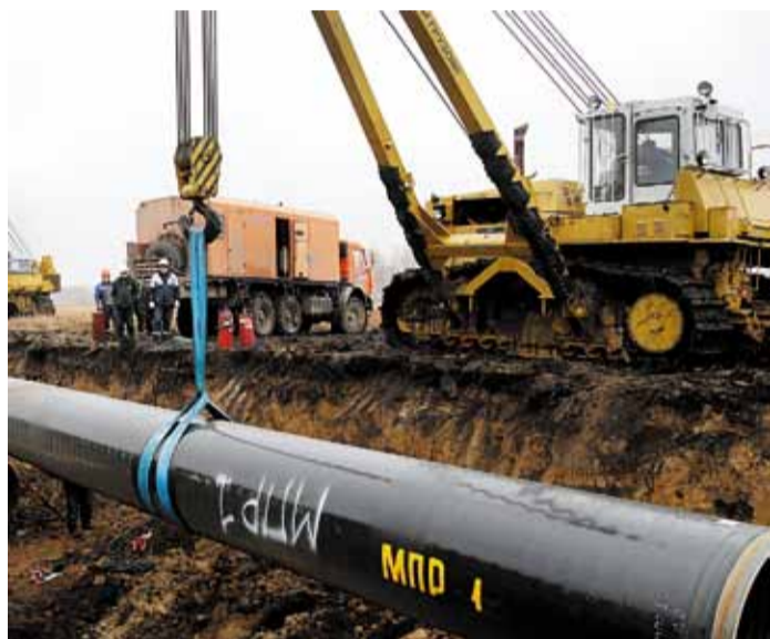
Осень 2013 года была ознаменована большим комплексом работ в Барабинском ЛПУМГ
